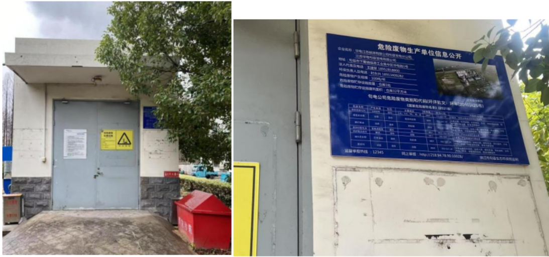
危废暂存间及标识牌
