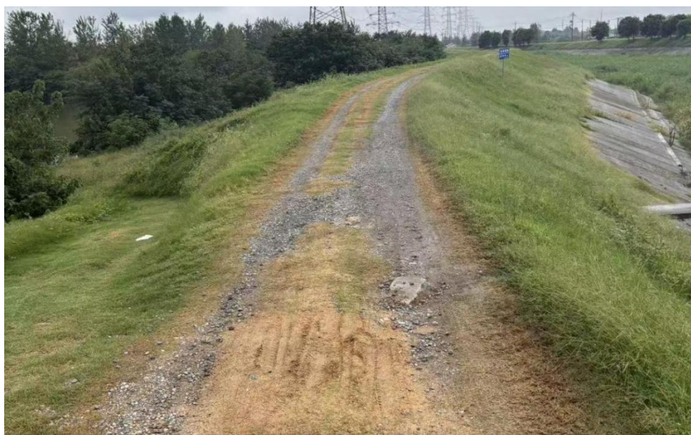
图 3-13 堤顶砂石路面结构
