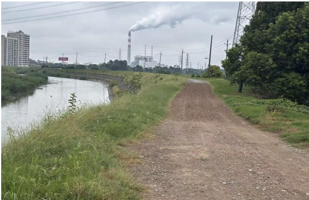
图 3-12 堤顶无路面结构
