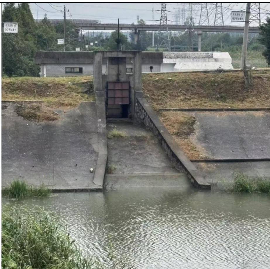
图 3-10 排涝站出水涵启闭系统无法正常运行
